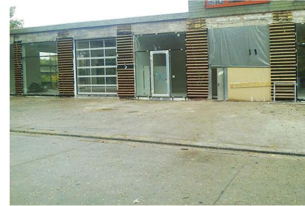
2014 - die ehemalige KFZ Grube. Diese diente zu Wartungsarbeiten von Werksfahrzeugen und wird nun vorbereitet um mit Glaselementen versehen zu werden.
