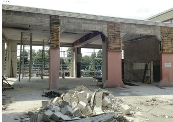
2013 - der östliche Teil des Gebäudes wird nahezu skelettiert. Die wasserseitigen Öffnungen wurden in den Stahlbeton geschnitten.
