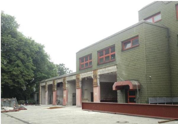
2013 - Stahlträger werden angeliefert. Diese werden eingezogen um tragende Wände zu ersetzen und die einzelnen Hallen zu verbinden.
