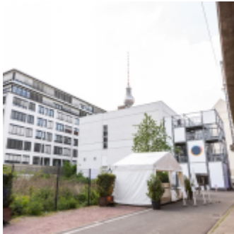
© Wahre Werte Umspannwerk Alexanderplatz Betriebsgesellschaft mbH
